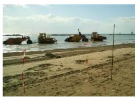
Figura IV.2.3.5.2 – ripascimento con "scraper" da accumuli di sedimenti in prossimità delle barriere
